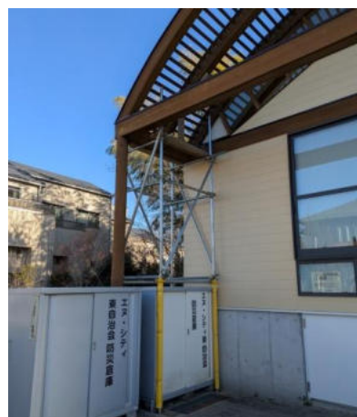
補強工事後の現状
